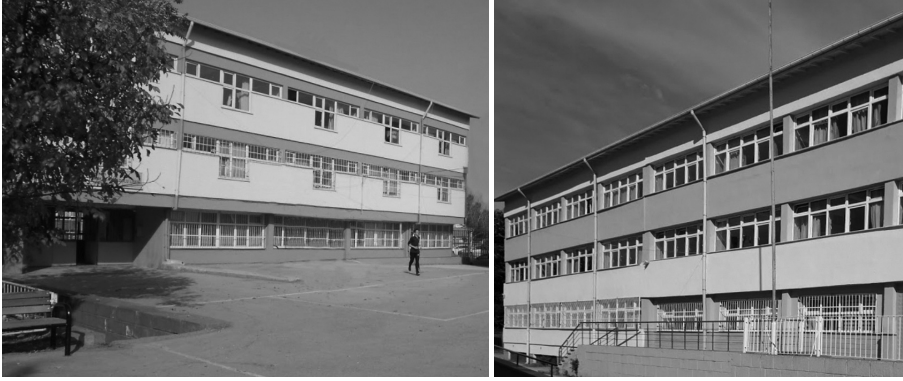
Şekil 1.2. Atatürk Anadolu Lisesi (Dışkapı Yerleşkesi-Altındağ) [4]
